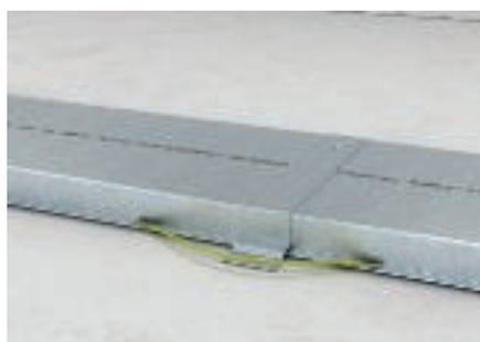
Verbindungsblaschen stellen die leitfähige Verbindung der beiden eingesteckten Kanäle her. Alternativ können Bauelemente auch durch externe Verbindungen, durch Löten, Schweißen, Nieten oder Schrauben leitend miteinander verbunden werden.
