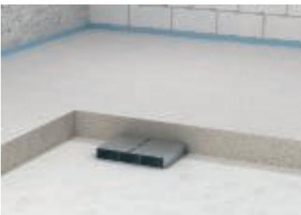
Im Zement-Verbundestrich ist die Montage der Unterflur-Installationskanäle schnell, einfach und ohne weiteren Schutz zu realisieren. Der Zementestrich kann direkt auf die verzinkten Stahlblechkanäle aufgebracht werden.
