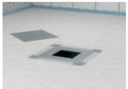
Durch Austausch des Montageschutzdeckels und Einbau eines „Montagedeckels DUG“ wird eine „Zug- und Abzweigdose UZD“ zur „Gerätedose UGD“.
