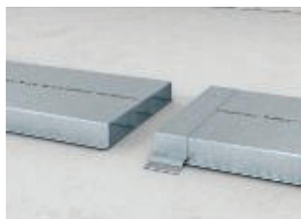
Nach dem Zuschchnitt der Kanäle können die Kanalverbinder positioniert werden.
