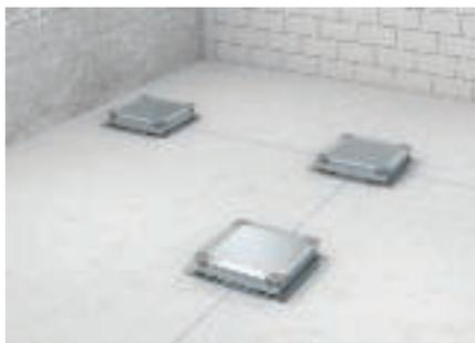
Mit einer Schlagschnur können auf dem Rohboden die geplanten Kanalwege und Kreuzungspunkte angezeichnet werden. Danach werden die Unterflurdosen ausgelegt.
