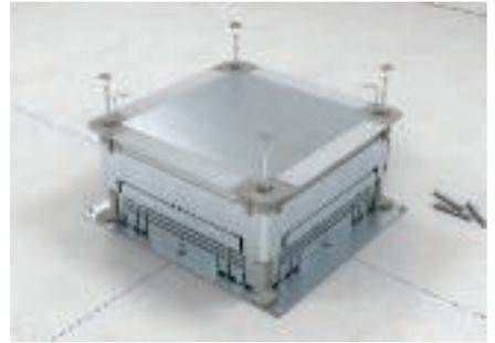
Den neuen Dosenoberrahmen wieder aufsetzen, Schrauben einstecken, Schnellverriegelungshilfe entfernen, die Schrauben mit den Verriegelungsdeckeln abdecken.
