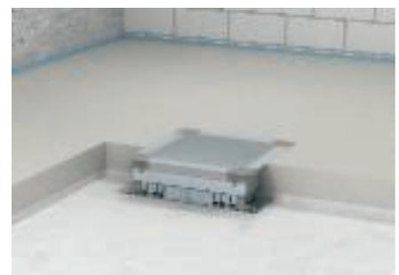
Anhydrit-Fließestrich wird dünnflüssig eingebracht. Dazu sind alle Öffnungen des Dosenkörpers mit geeigneten Mitteln abzudichten (z.B. Klebebänder).
