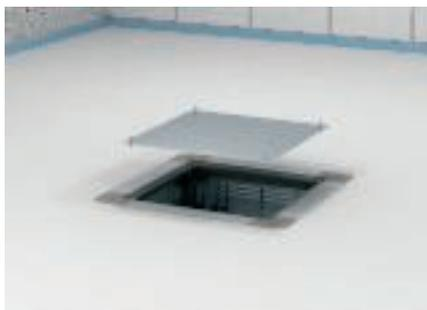
Der Montageschutzdeckel wird nach der Estrichverlegung gegen einen Montagedeckel gewechselt. Hinweis: Öffnungen müssen während der Bauphase trittsicher abgedeckt sein.
