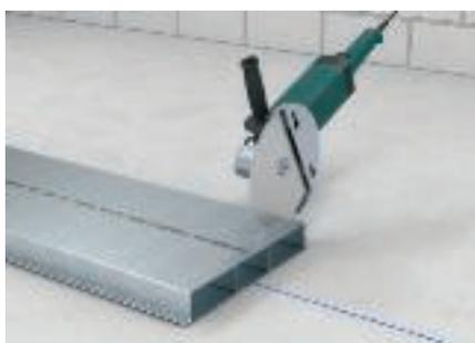
Die Stahlblechkanäle lassen sich am einfachsten mit einem Einhand-Winkelschleifer bearbeiten. Saubere Schnitte sowie die anschließende Entgratung sind wichtig für eine schonende Installation der Kabel und Leitungen.
