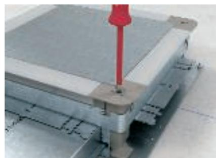
Die Feineinstellung der Dosenhöhe erfolgt über die Nivellierschrauben. Das Nivellieren ist mit der Bauleitung/Estrichfirma (Meterriss) abzustimmen.
