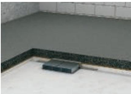
Auch im Gussasphalt als Verbundestrichsystem mit einer Einbautemperatur von ca. 280 Grad Celsius ist der Einsatz von Unterflur-Installationskanälen möglich. Eine Bitumen-Wellpappe muss hier jedoch aufgelegt werden und sorgt für den Schutz der Kanäle während des Einbringens und der Auskühlphase des Estrichs. Die Installation der Kabel und Leitungen kann natürlich erst nach der Auskühlphase erfolgen.
