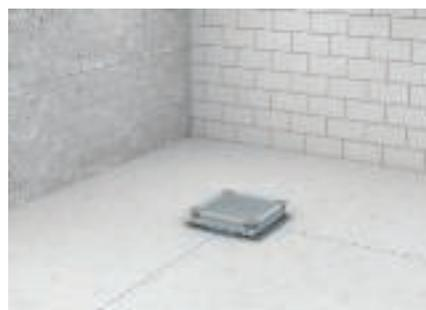
Unterflurdosen werden auf den Linien sowie den Kreuzungspunkten ausgerichtet und befestigt. Danach lässt sich die benötigten Kanallänge ermitteln.
