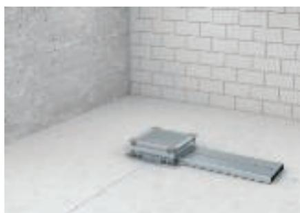
Die Längen der Kanalstrecken lassen sich nun genau ermitteln. Das Material kann auf dem Boden ausgelegt werden.
